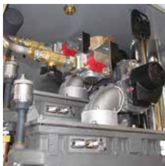
Egységek: ventilátor, modulációs gázszelep, premix égő
